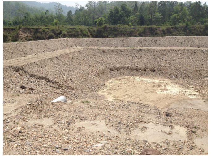
चित्र ३: सर्लाहीको लखनदेही खोलाको किनारमा निर्माणाधिन पुनर्भरण पोखरी
